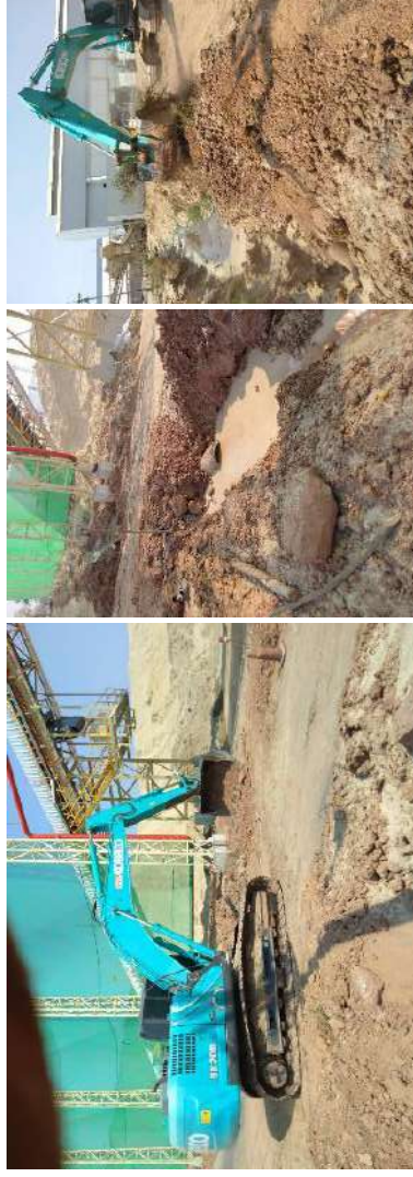
เตรียมขาน้อย ทำคันดินข้างทางเข้ากองขาน้อย ป้องกันรถบรรทุกน้ำ ปรับพื้นที่ทางเข้าให้สม่ำเสมอ และแก้ไขทางน้ำไหล ทางเข้าขาน้อย
